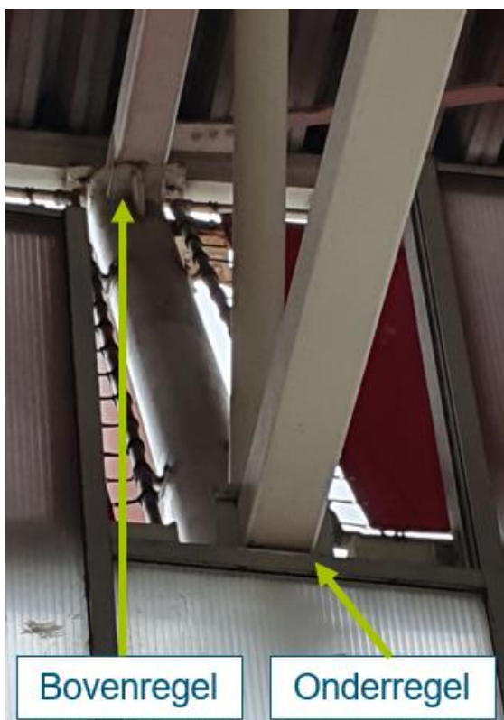
Figuur 2-11 Detailfoto van aansluiting van boven- en onderregel op kopplaten bij vakwerkligger 36
