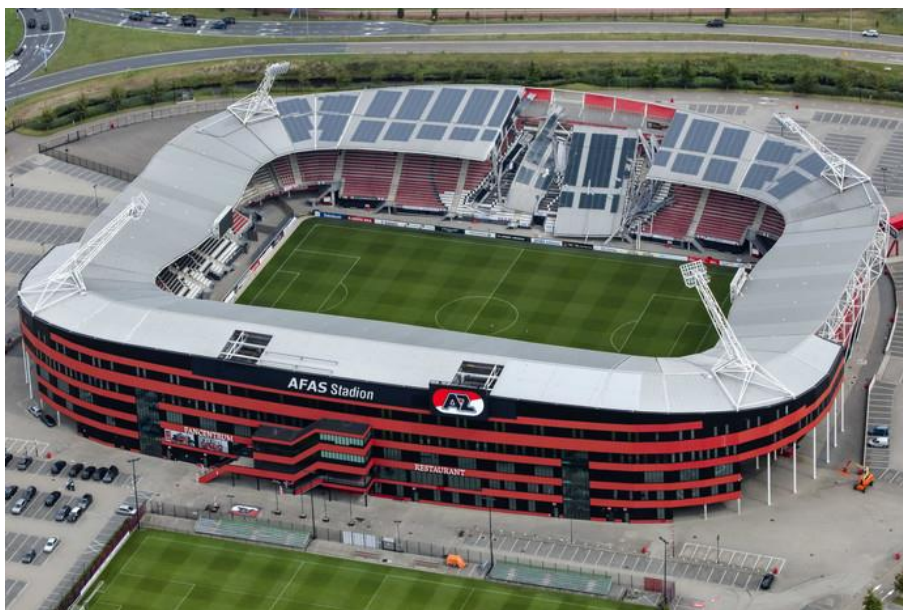
Figuur 1-1 Foto AFAS Stadion met gedeeltelijk ingestorte dakconstructie [1]
