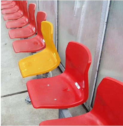
Figuur 2-18 Lichte schade aan stoelen
