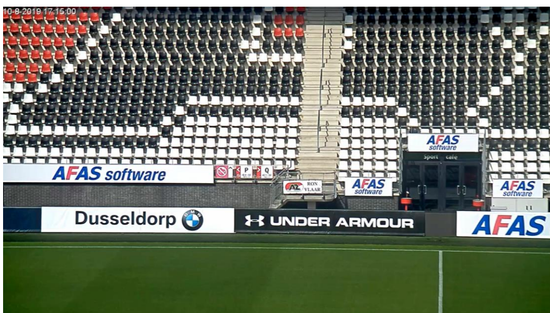
Figuur 4-1 Camerabeeld van een deel van de tribune waar de instorting plaatsvindt
