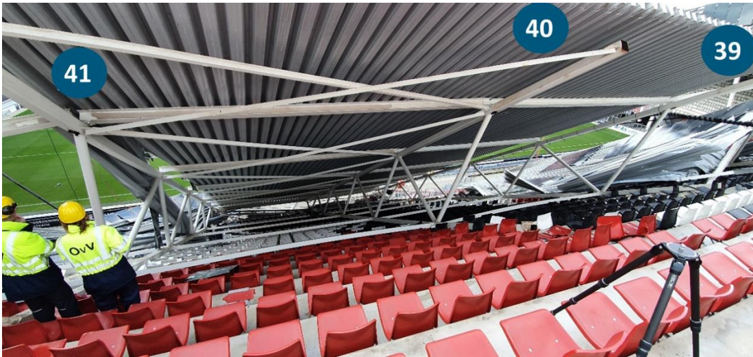
Figuur 2-8 Vakwerkliggers 39 t/m 41 gezien vanaf de bovenzijde van de tribune
